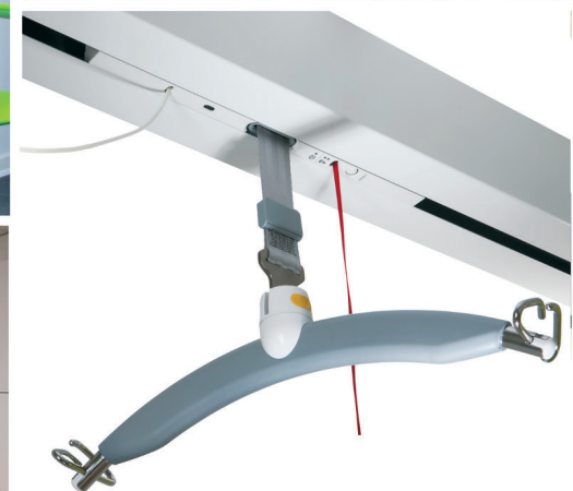
Nouveau moteur GHZ intégré dans le rail
